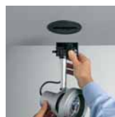
Instalace s adaptérem do podhledu
